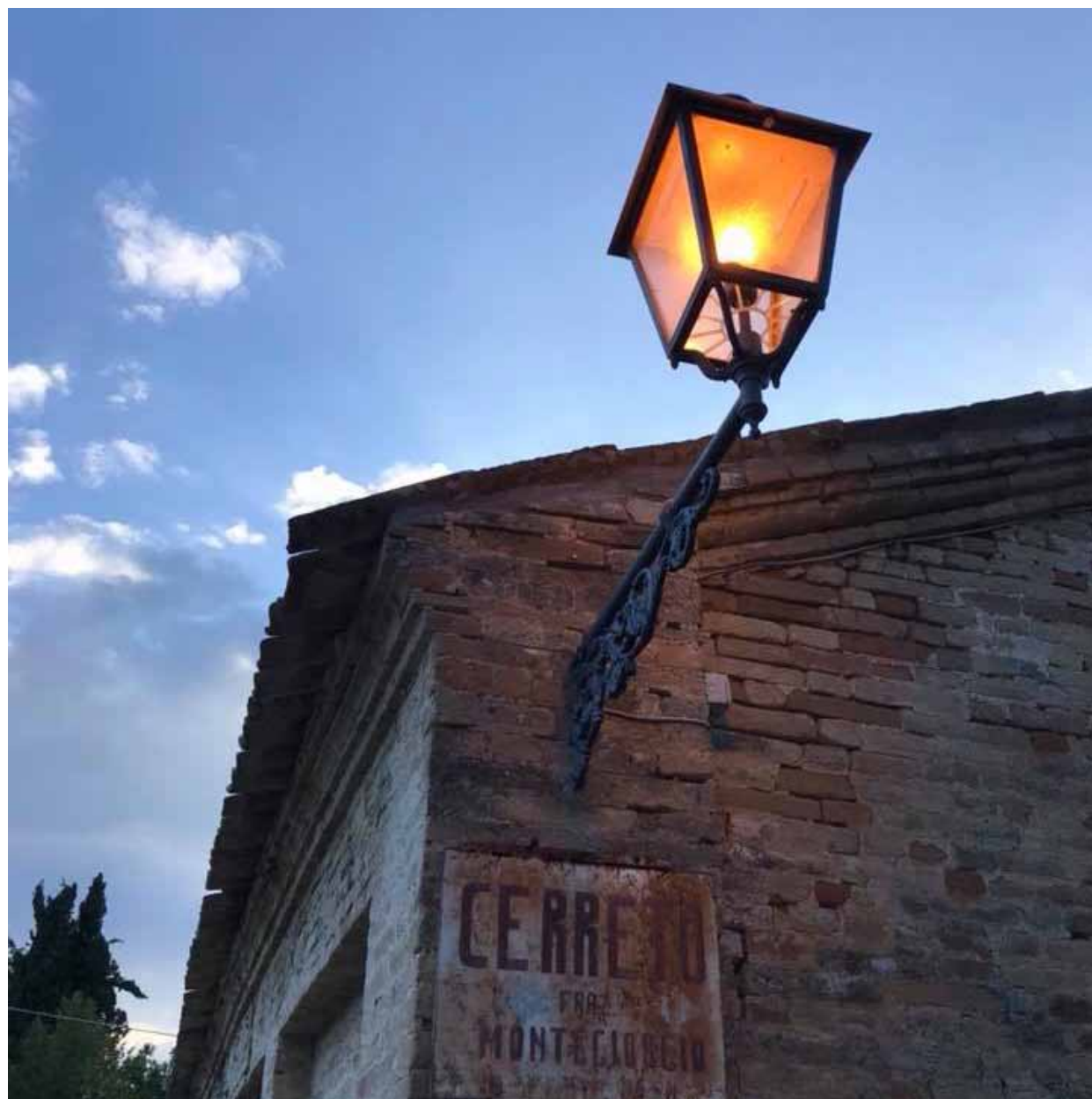
Montegiorgio: uno squarcio di un'epoca passata in una delle frazioni
